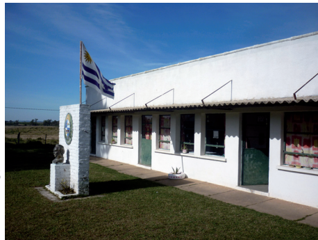
Escuela Rural Nº 65, Las Arenas
