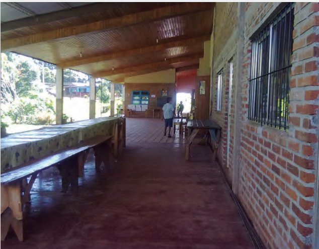
Galería semi-cubierta destinada a usos varios. Escuela N°570, Aristóbulo del Valle, Misiones.
