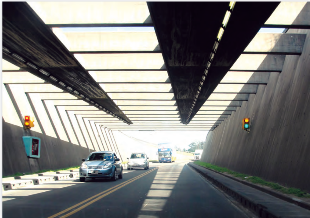
Túnel Subfluvial Uranga-Begnis, Paraná (Entre Ríos) - Isla Santa Cándida (Santa Fe).
