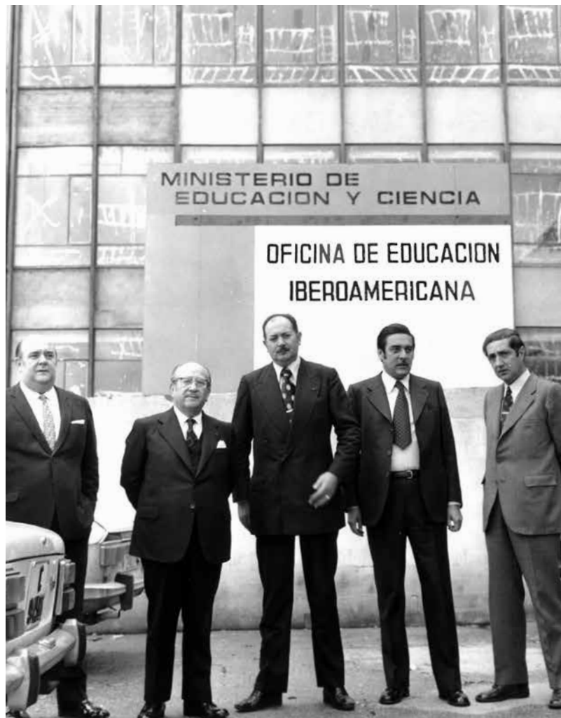
Secretário Geral da OEI, Barón Castro, com outras personalidades, na obra do edifício. Cidade Universitária, Madri, 1974
