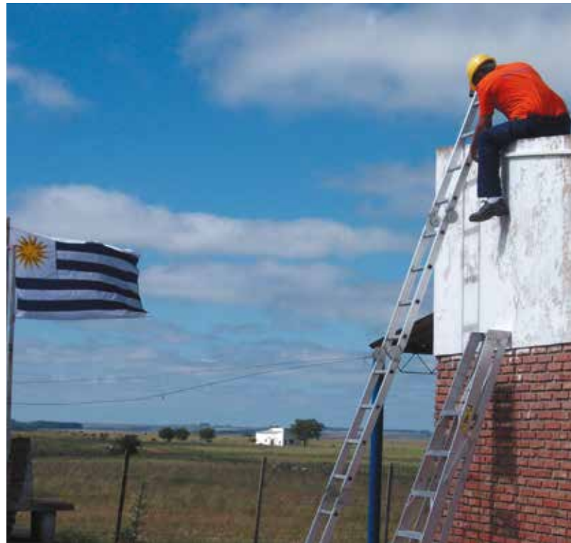
Trabalhador instalando painéis de energia solar na escola. Uruguai, 2015
