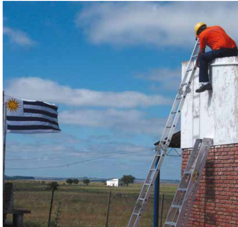
Operario colocando paneles solares en escuela. Uruguay, 2015
