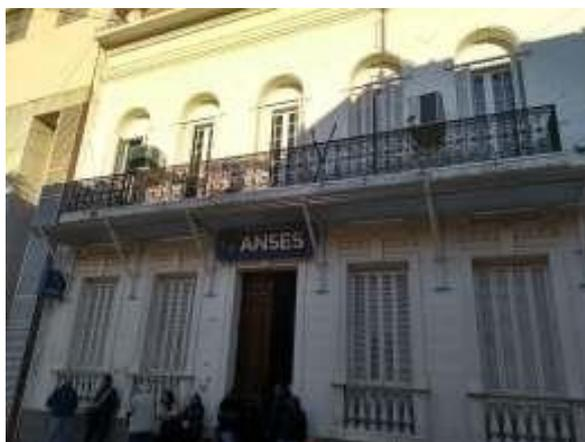
La fachada frente del edificio posee el muro exterior revestido en material similar piedra París, con apliques pre-moldeados sobre las aberturas en ambas plantas. La planta baja posee en toda su extensión un revestimiento de placas de mármol.
