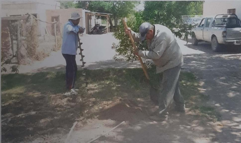
Foto 4: Iniciando sondeo S.3. Alcanzó cota - 2,46 mts. en suelos arenas finas
