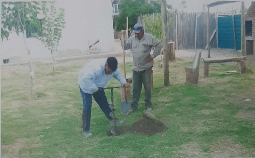
Foto 3: Profundizando sondeo S.2. Alcanzó la cota -1,97 mts. Aquí se tomó
