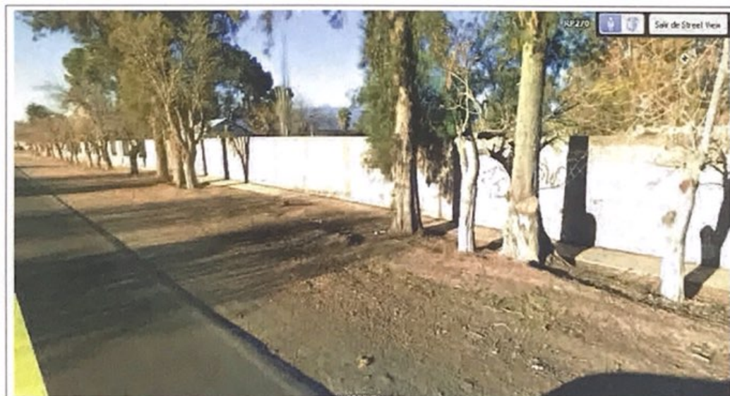
Fotografía N°2: Se muestra una imagen general del frente del terreno estudiado perteneciente a la Escuela de Nivel Inicial ENI N°41 Dante Alberto Saavedra.
