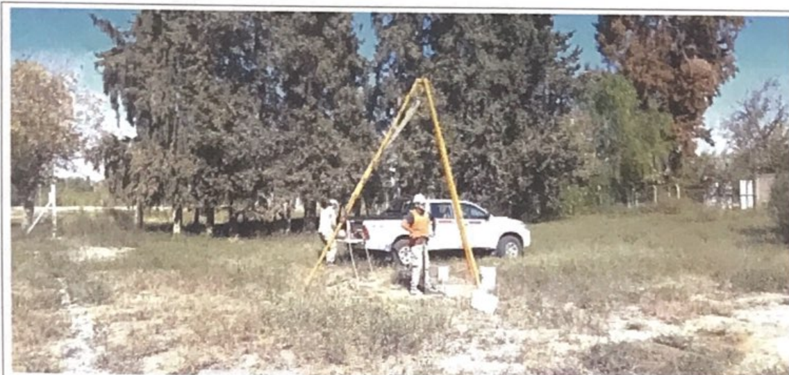
Fotografía N°15: Vista de la posición en el terreno del Sondeo S.2. Se observan los trabajos de perforación y toma de muestra, como así también el ensayo de penetración estándar (SPT).
