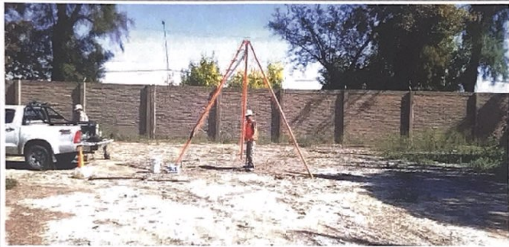
Fotografía N°9: Vista de la posición en el terreno del Sondeo S.1. Se observan los trabajos de perforación y toma de muestra, como así también el ensayo de penetración estándar (SPT).
