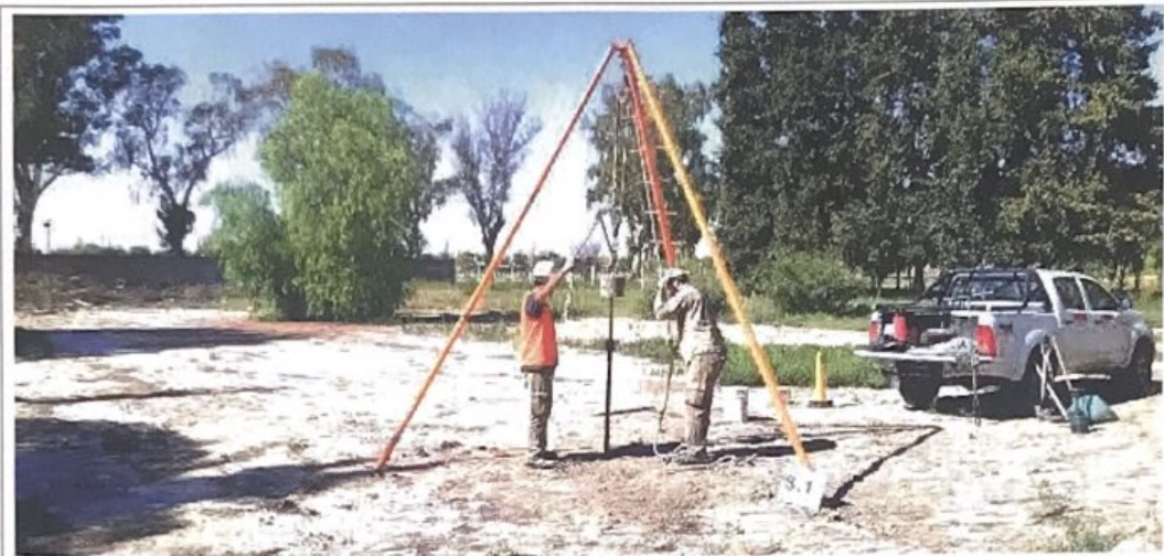
Fotografía N°13: Vista de la posición en el terreno del Sondeo S.1. Se observan los trabajos de perforación y toma de muestra, como así también el ensayo de penetración estándar (SPT).
