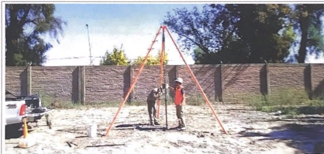
Fotografía N°12: Vista de la posición en el terreno del Sondeo S.1. Se observan los trabajos de perforación y toma de muestra, como así también el ensayo de penetración estándar (SPT).
