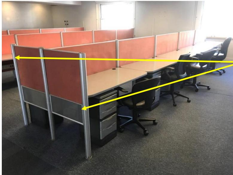
PATAS A RETIRAR (JUNTO CON ESOS PANELES LATERALES), SE DEBEN CORTAR A LA ALTURA DEL ESCRITORIO Y VOLVERLAS A FIJAR
