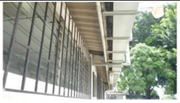
Canal y techo
