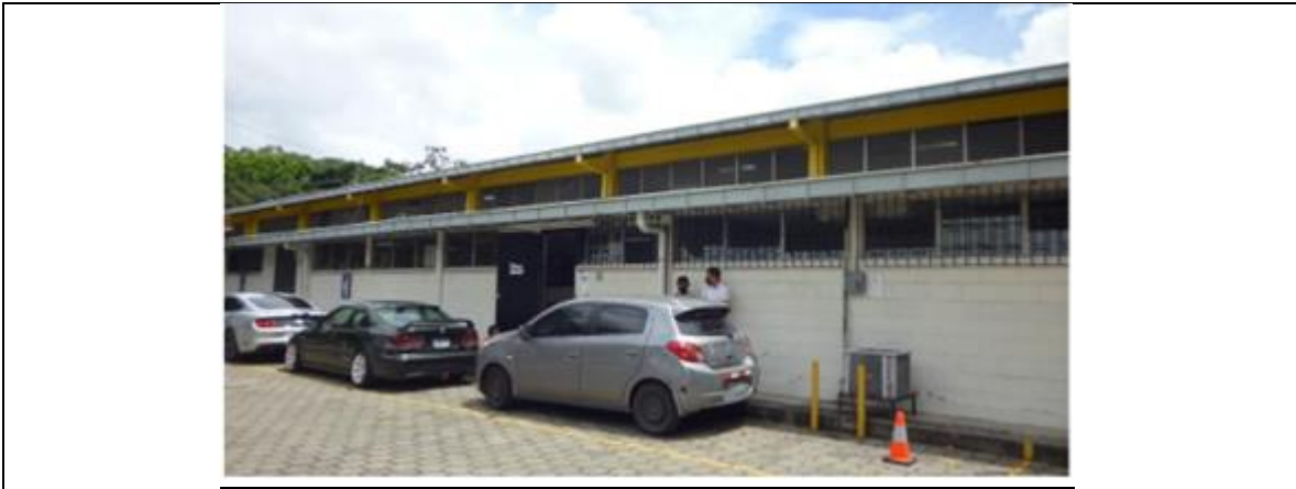
Fachada general de instalaciones
