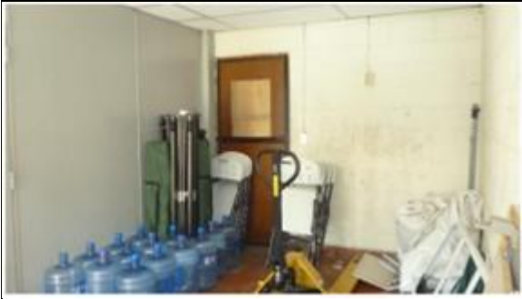
Area de vestibulo hacia talleres
