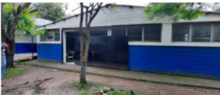
ACCESO Y TECHO Fotografía No. 5
