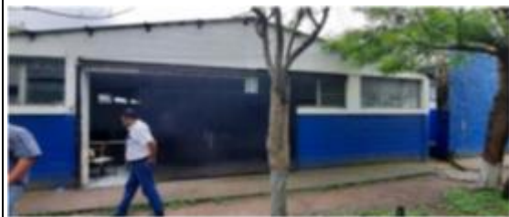
DESMONTAJE DE PORTON Y CONSTRUCCION DE PARED DE BLOQUE E INSTALACION DE PUERTA Fotografía No. 4
