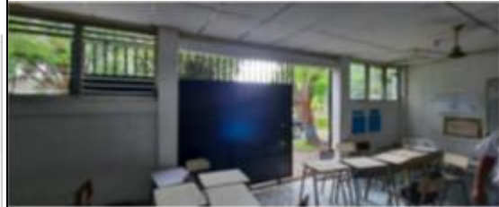
REPARACIÓN DE VENTANAS Fotografía No. 2
