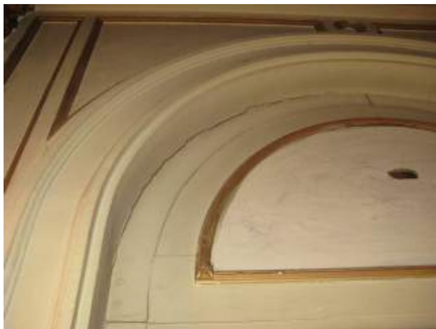
22-JUNTA ABIERTA EN CARPINTERIA-MICROORGANISMOS-VIDRIO
