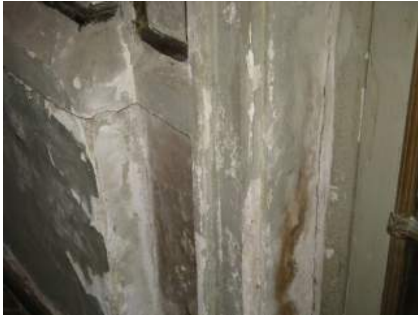
51-MANCHAS DE HUEMDAD-MICROORGANISMOS-SALES SOLUBLES EN SUPERFICIE
