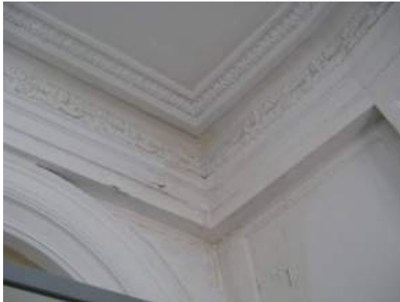
25-DESPRENDIMIENTO DE CAPA PICTORICA-PERDIDA DE RELIEVE
