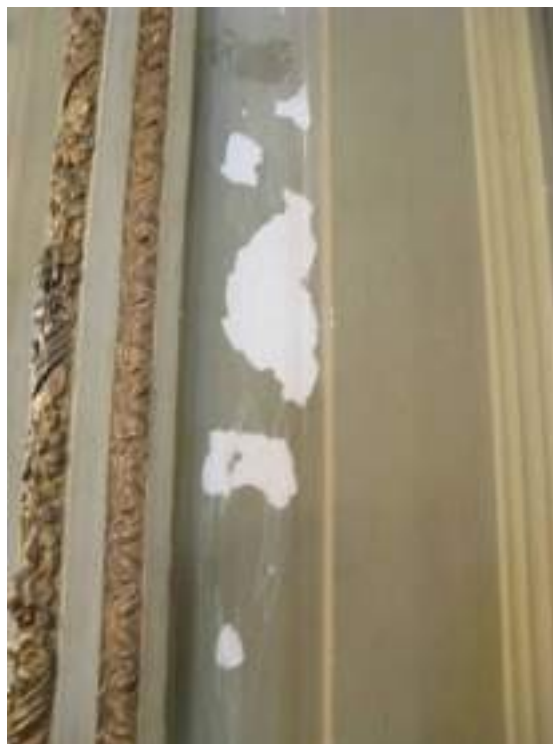
16-DESPRENDIMIENTO-CAPA PICTORICA-RAYADURA
