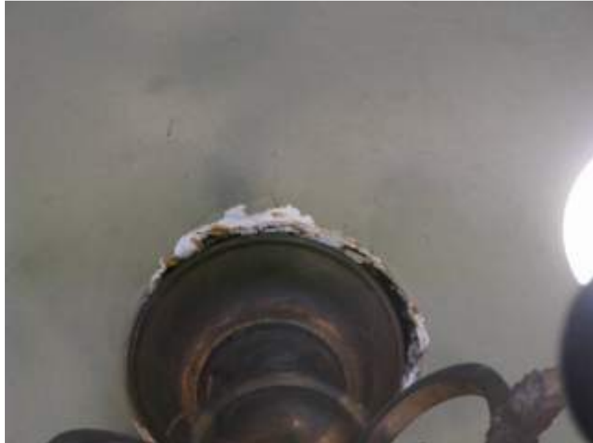
44-FALTANTES PARCIALES-FISURAS
