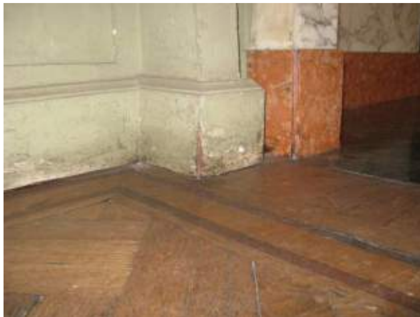
40-FALTANTE PARCIAL-PERDIDA DE RELIEVE-RAYADURA
