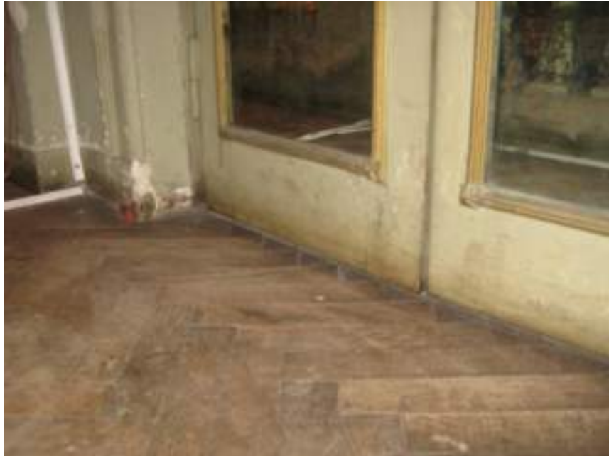
75-FALTANTE PARCIAL-FALTANTE TOTAL
