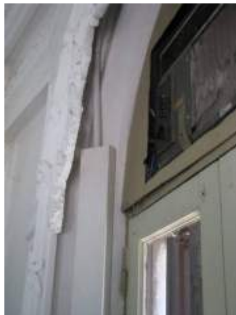
26-INSTALACION NO ORIGINAL
