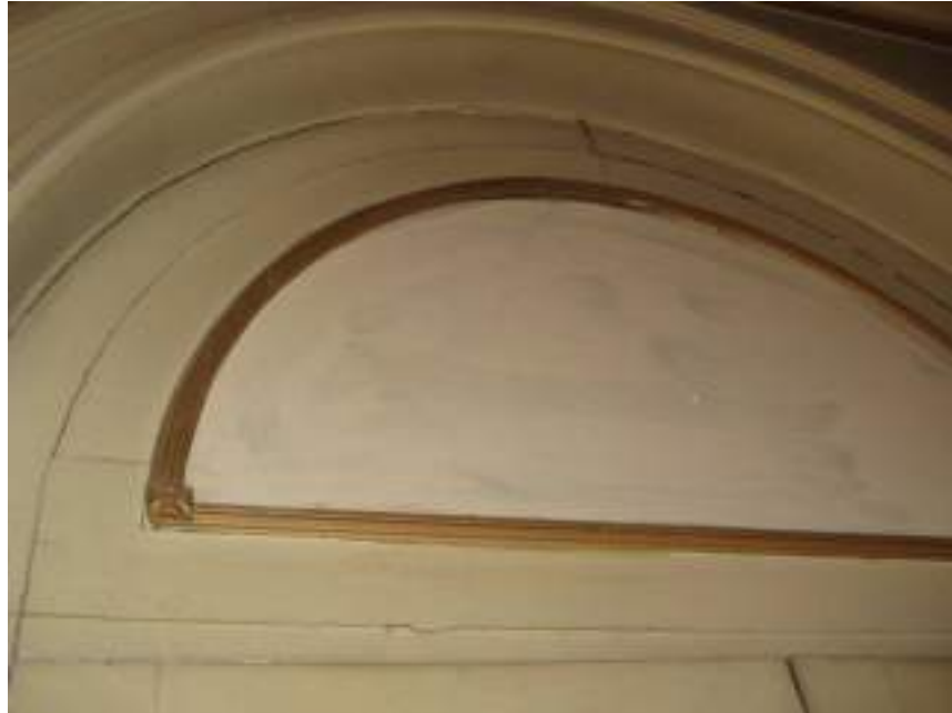
25-JUNTA ABIERTA EN CARPINTERIA-VIDRIO PINTADO
