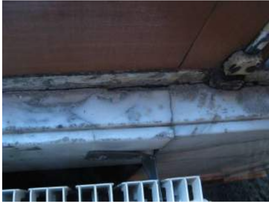
11-INSTALACION NO ORIGINAL-MANCHAS-PERDIDA DEL RELIEVE-PERFORACIONES
