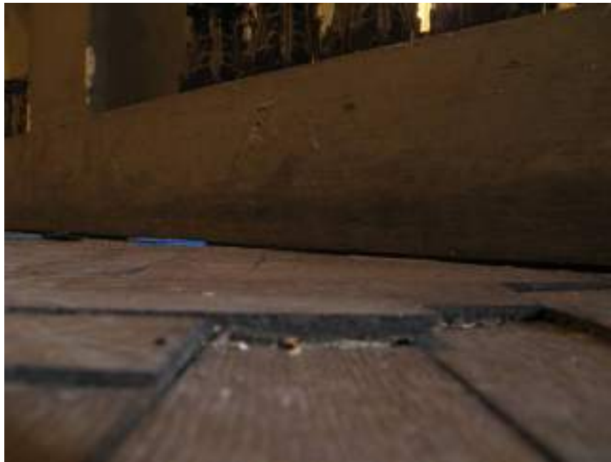
13-PA-DESNIVEL-JUNTAS ABIERTAS
