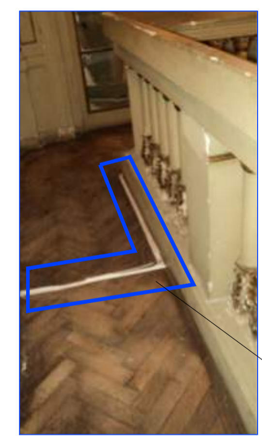
EL CABLEADO DE DATOS QUE SUBE DESDE PLANTA INFERIOR IRA POR PISO QUE SERA REMOVIDO Y REFACCIONADO HASTA BOCA PARA ALIMENTAR EL PROYECTOR.
