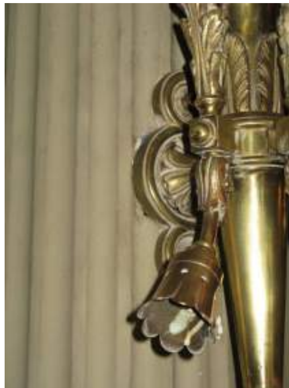
26-INSTALACION NO ORIGINAL-FALTANTE DE LAMPARA
