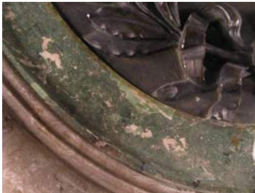
8-INTERVENCION PRECEDENTE-SUCIEDAD SUPERFICIAL
