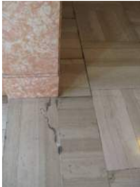
5-PI-JUNTA ABIERTA-SUCIEDAD SUPERFICIAL
