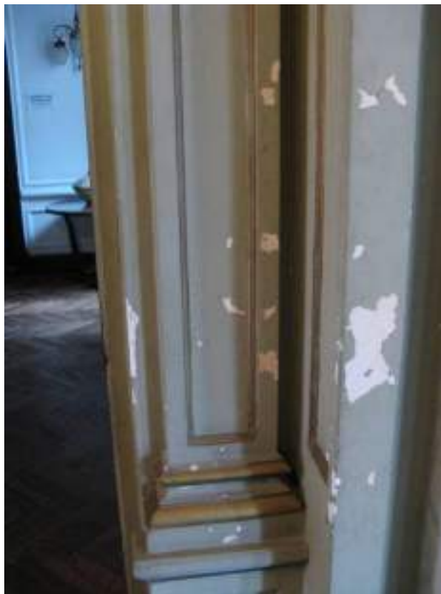
28-DESPRENDIMIENTO DE CAPA PICTORICA-PERDIDA DE RELIEVE
