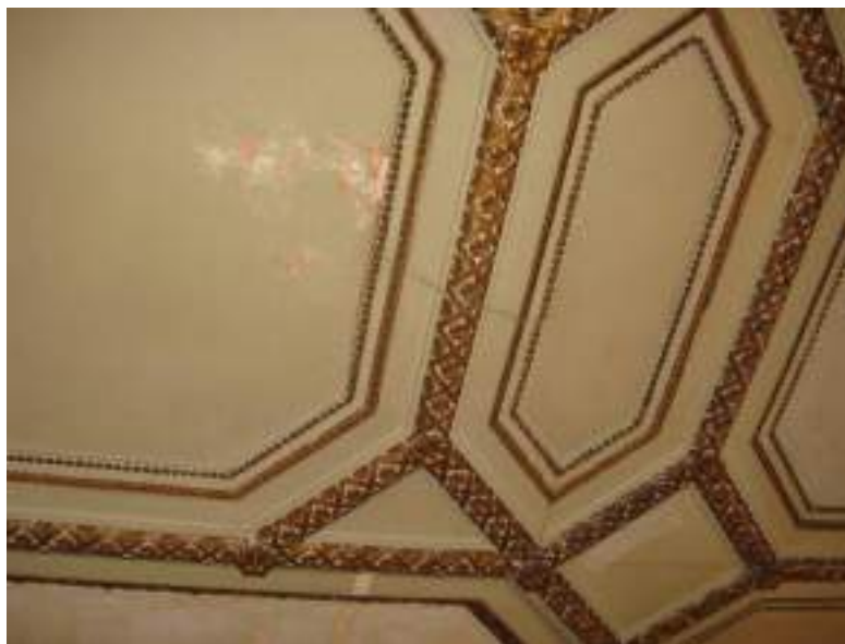
2-FISURAS-DEFORMACION
