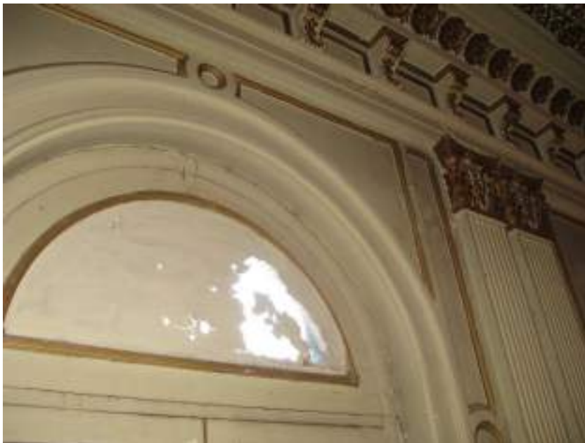
40-VIDRIO PINTADO-JUNTA ABIERTA EN CARPINTERIA
