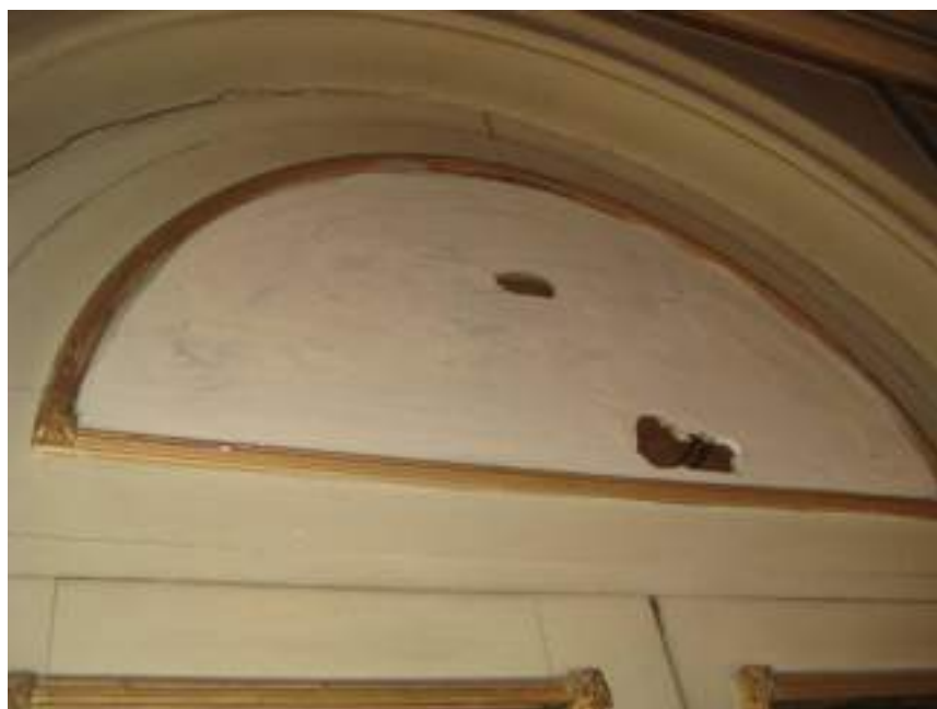
23-JUNTA ABIERTA EN CARPINTERIA-VIDRIO PINTADO
