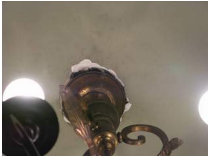
42-FALTANTES PARCIALES-MANCHAS DE OXIDO
