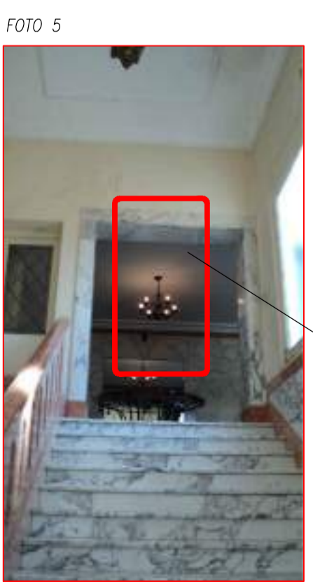
ARAÑA EXISTENTE A RESTAURAR Y A REEMPLAZAR 6 LAMPARAS EXISTENTES POR LAMPARAS DE LED TIPO MASTERLED A60 12W
