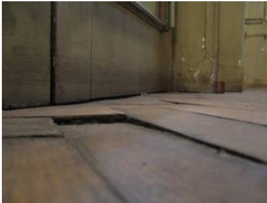
3-PA-DESNIVEL-JUNTAS ABIERTAS
