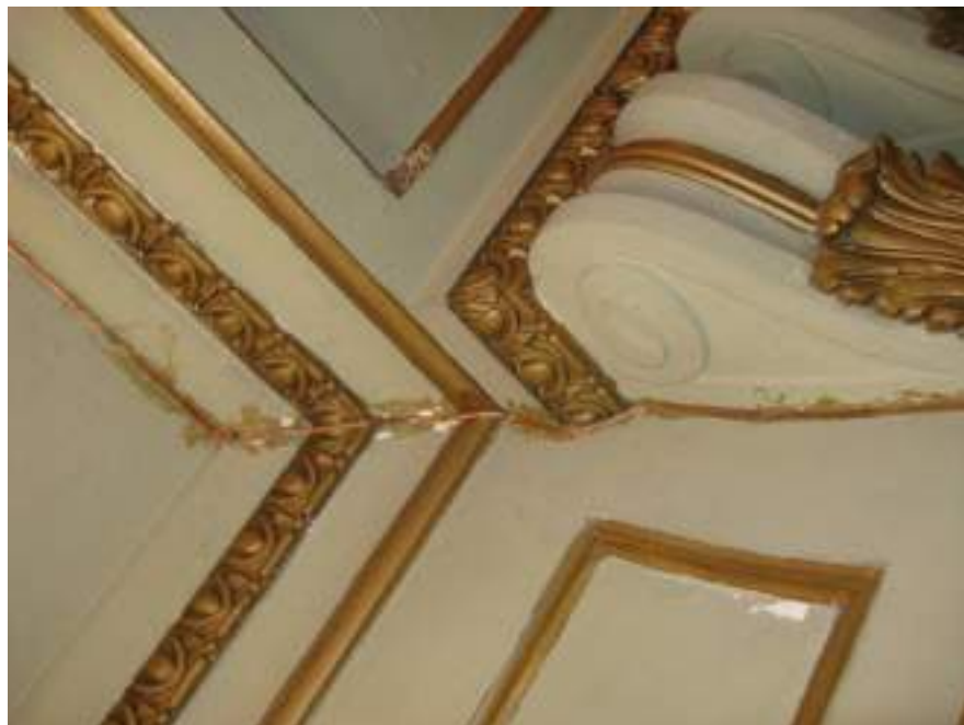
24-INSTALACION NO ORIGINAL-INTERVENCION PRECEDENTE
