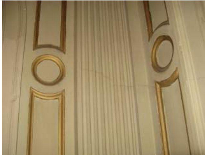
9-FISURAS-FALTANTE PARCIAL
