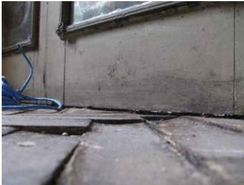
11-PA-DESNIVEL-JUNTAS ABIERTAS
