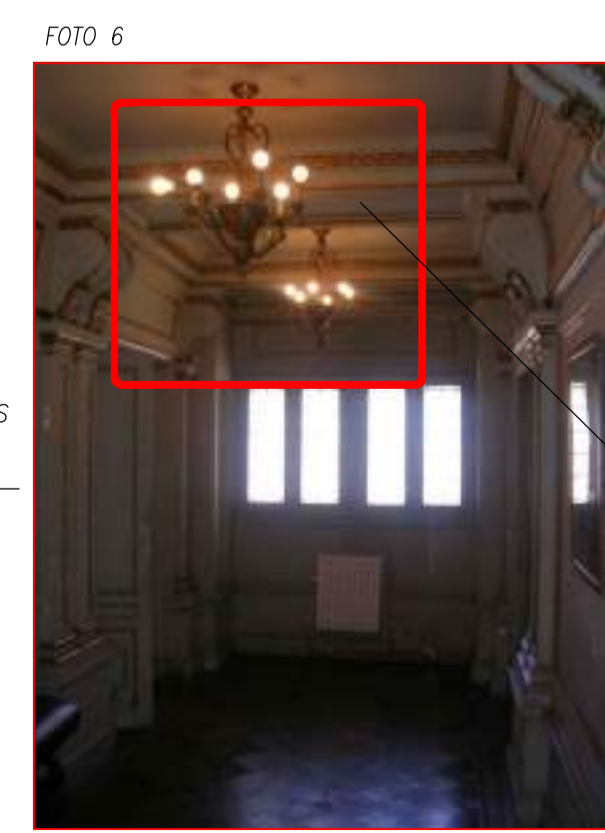
ARAÑA EXISTENTE A RESTAURAR Y A REEMPLAZAR 6 LAMPARAS EXISTENTES POR LAMPARAS DE LED TIPO MASTERLED A60 12W
