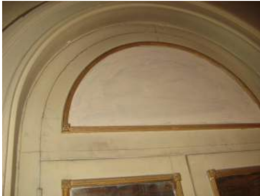
16-VIDRIO PINTADO-JUNTA ABIERTA EN CARPINTERIA
