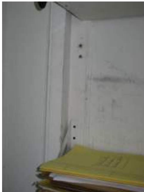
2-INTERVENCION PRECEDENTE-PERFORACIONES-RAYADURA
