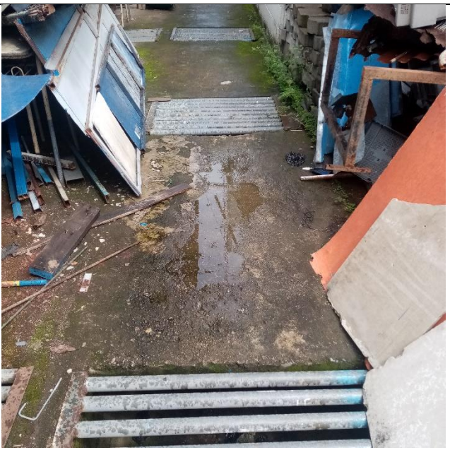
Condición del piso donde hay una canalera de desalojo de aguas lluvias, aquí se colocara una estructura metalica de nivelacion, luego una superficie de material liviano y sobre esto piso ceramico.
