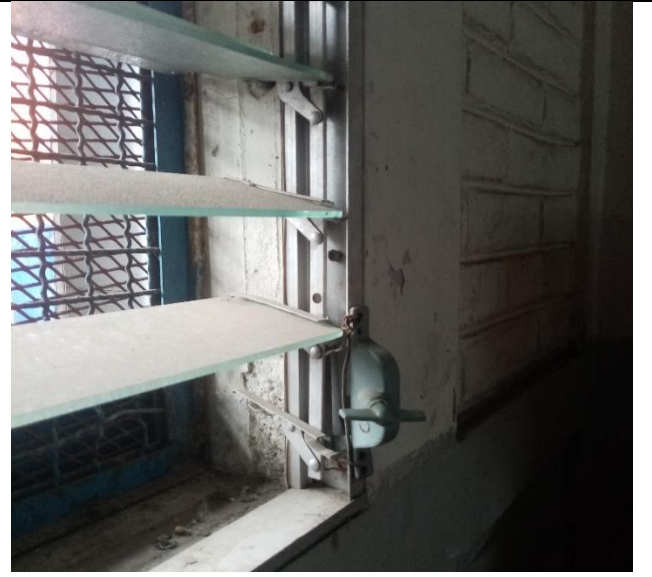
Estas ventanas de celosía de vidrio, se sustituirán por vidrios fijos.
