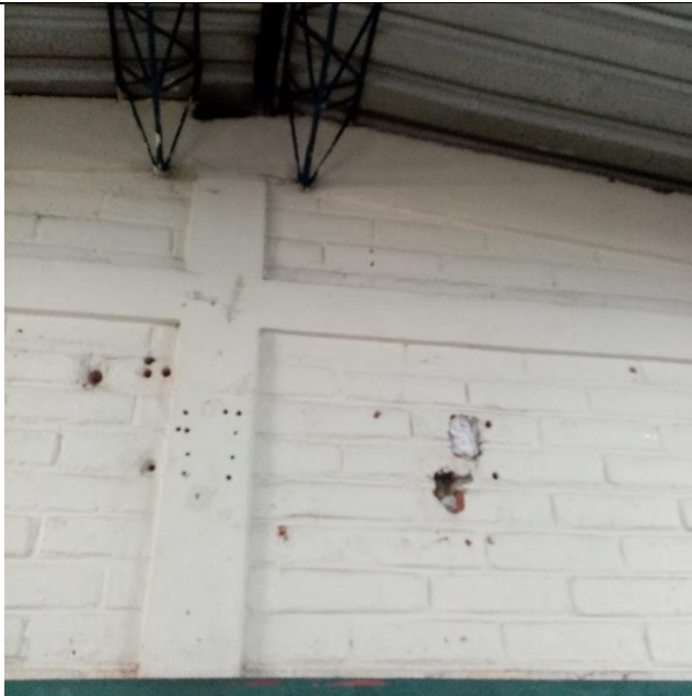
Repello de paredes en mal estado, resane de fisuras y oquedades.
