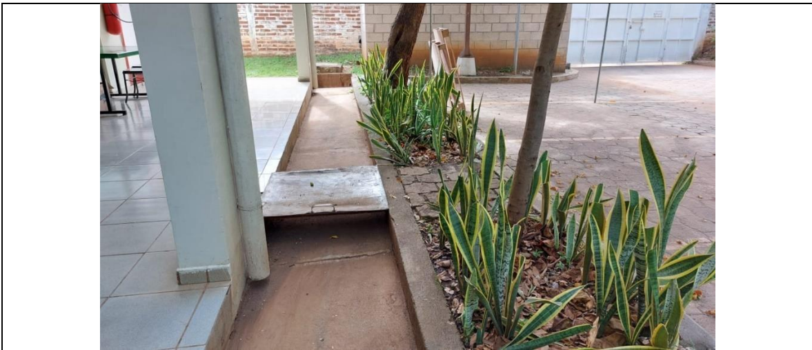
Área a intervenir con rampa de acceso
