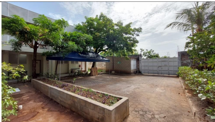
Fachada general de instalaciones
