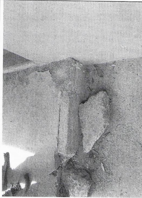
Grada a reparar
