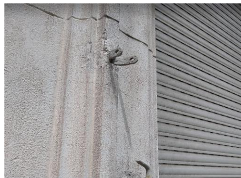
Elementos correspondientes al sistema de toldos originales del edificio, a conservar y restaurar.
