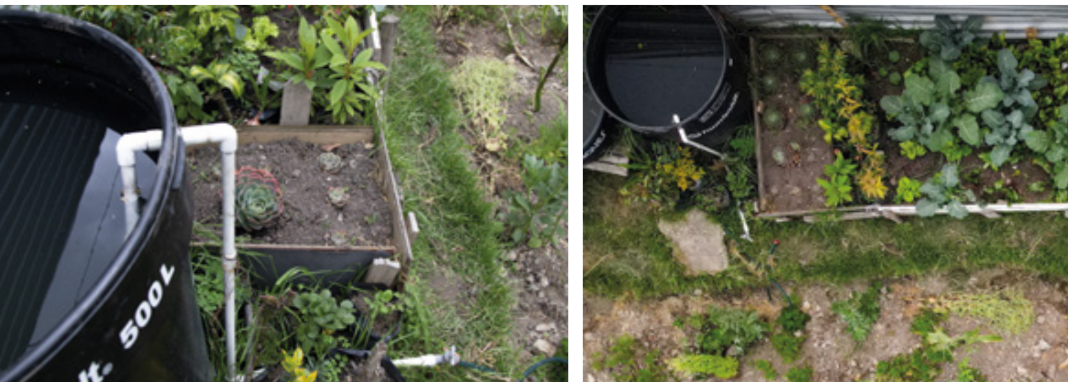
Figura 30. Captación de agua lluvia
