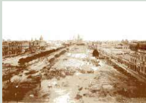
Demoliciones para formar la plaza del Congreso
