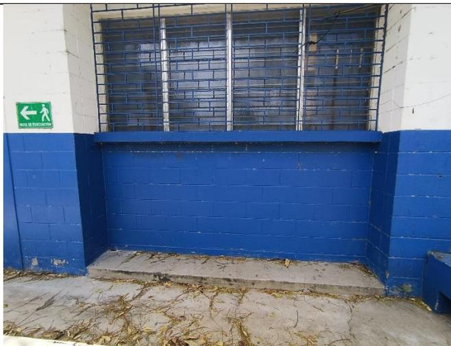
Ventana de aluminio y celosía de vidrio en buenas condiciones, defensa metálica en buenas condiciones.
