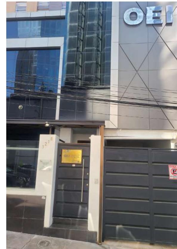
Fachada de la Oficina de la OEI en Bolivia.
